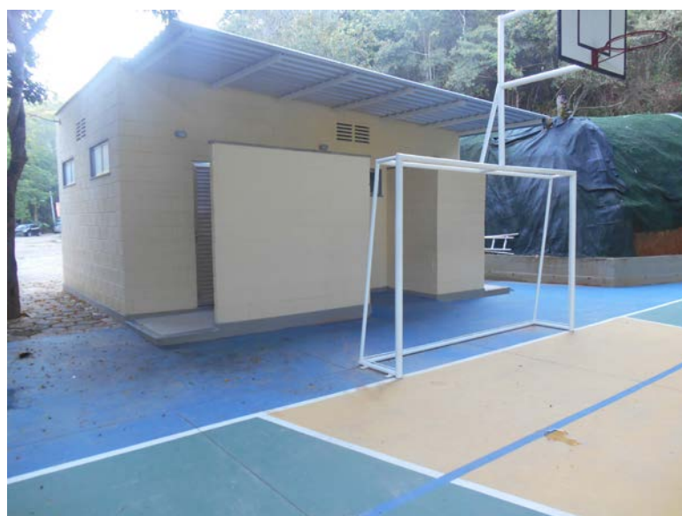
Após alguns meses, a obra foi finalizada
